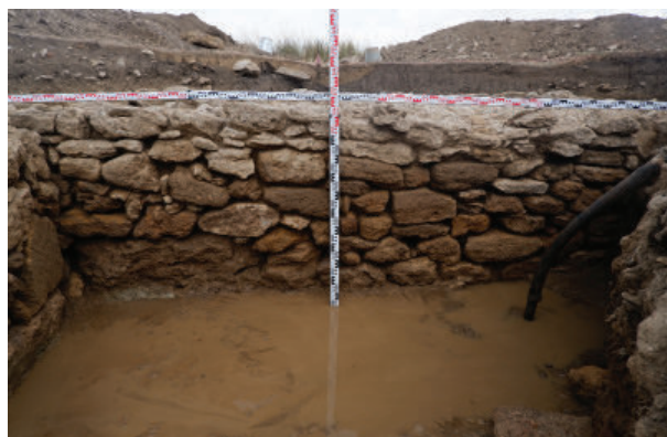
Рис. 5. Акра 2023. Юго-западная стена полуподвала
