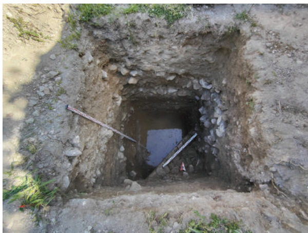
Рис. 8. Шурф 5, проступившие грунтовые воды. Вид с юга
