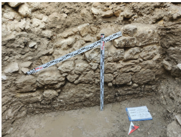
Рис. 9. Шурф 5. Каменная кладка. Вид с северо-запада
