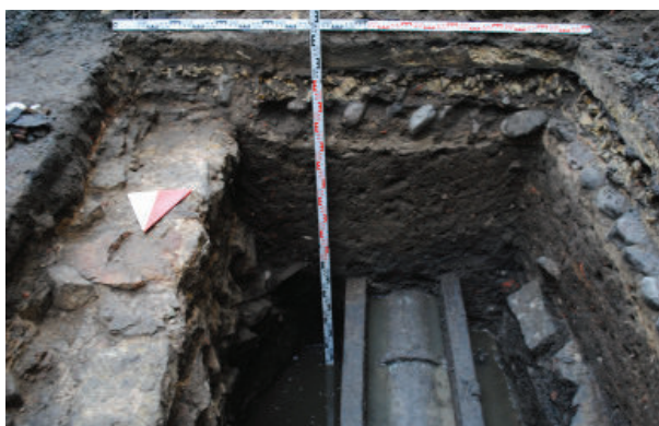
Рис. 10. Большая Подьяческая ул., д. 24. Фиксация южной стенки шурфа и уходящих в нее фундамента и асбестового трубопровода. Фотография ИИМК РАН, 2018
