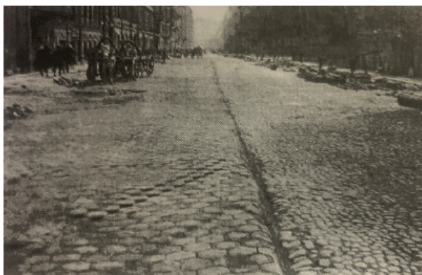
Рис. 5. Ремонт подземных коммуникаций на ул. Восстания. Фотография, 1934 (Бажанов, 1996. С. IX)
