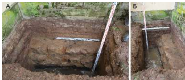
Рис. 11. Манеж 146-го Царицынского полка. Шурф № 1: А – вид с северо-востока; Б – вид с северо-запада
