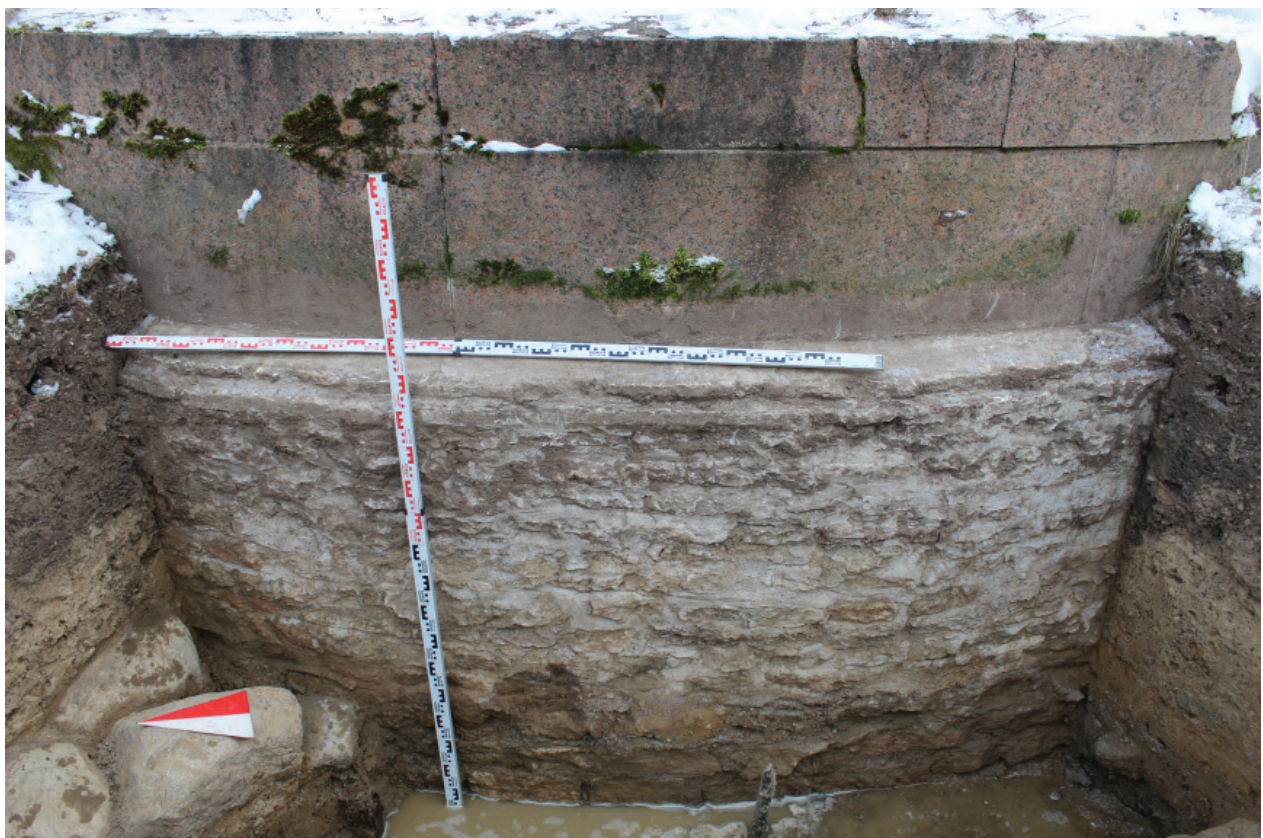
Рис. 11. Петергоф 2012–2013. Нижняя дача. Шурф 3. Фрагмент фундамента дворца. Вид с запада
