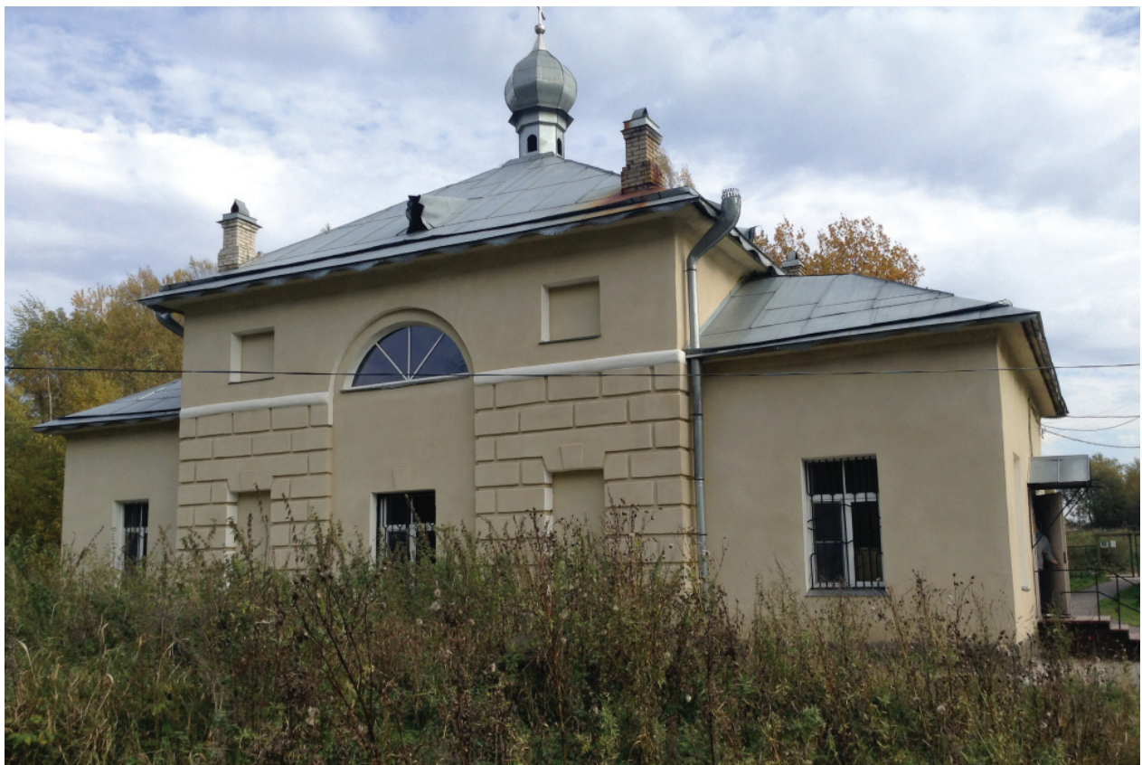
Рис. 4. Церковь Покрова Пресвятой Богородицы в пос. Шапки в здании бывшей усадебной библиотеки (с августа 1992 г.). Вид с запада
