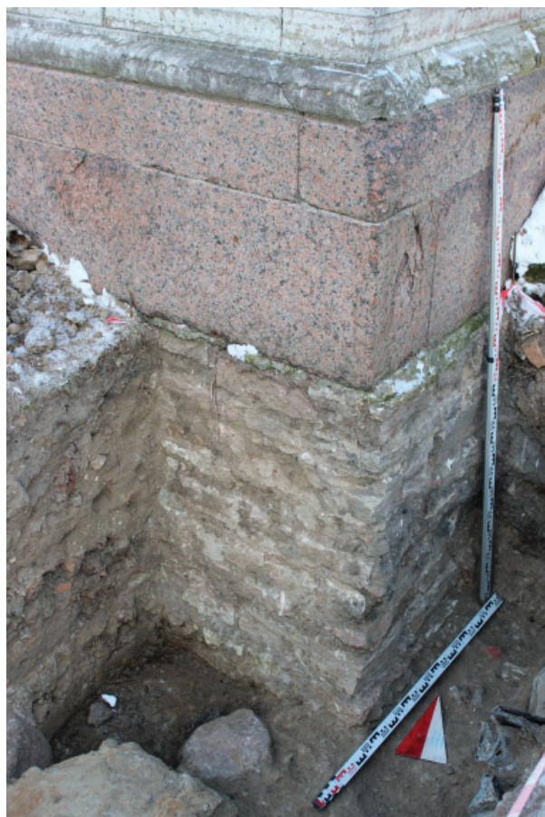
Рис. 6. Петергоф 2012–2013. Нижняя дача. Шурф 1. Фрагмент фундамента дворца. Вид с юго-востока
