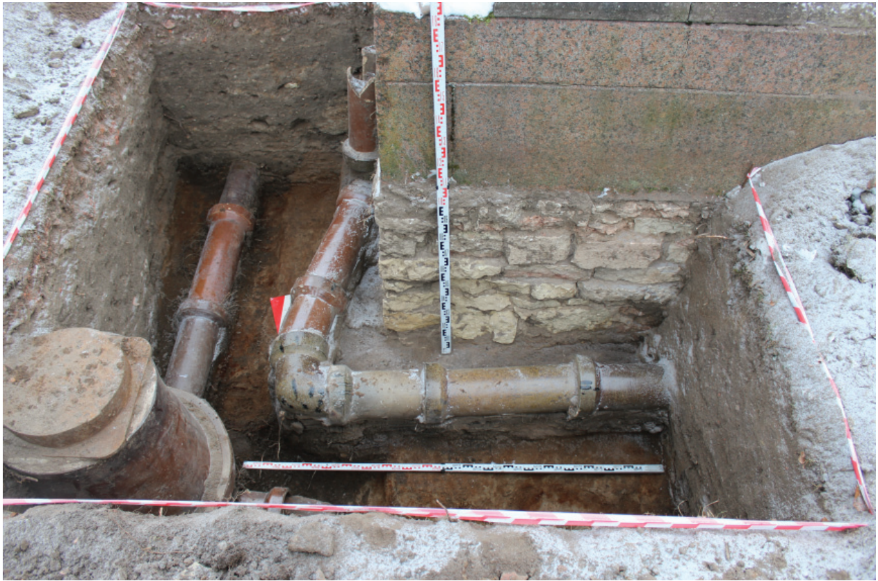
Рис. 8. Петергоф 2012–2013. Нижняя дача. Шурф 2. Фрагмент фундамента дворца и керамические трубы системы водоотведения. Вид с севера
