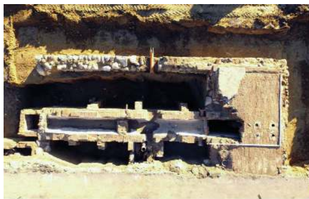
Рис. 10. Коллектор на западном борту котлована. Вид сверху
