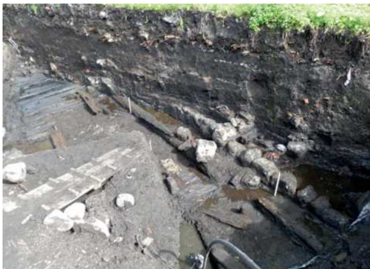
Рис. 14. Основание двухкамерного дома и южной части конюшни горизонта 5 раскопа 2004 г. в уровне горизонта 5 раскопа 2012 г. у дома № 8 по ул. Выборгская. Фото. Вид с СЗ
