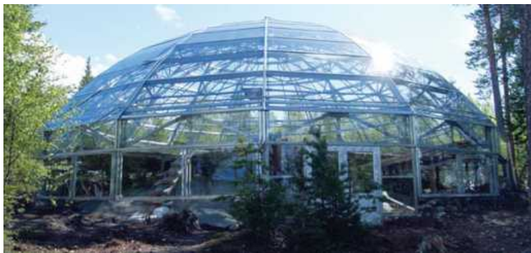
Рис. 21. Канозеро: остров Каменный. Защитное сооружение над группой Каменный-7
